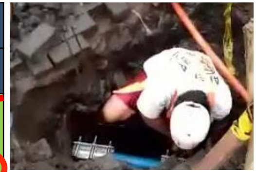
Proses penggantian pipa akibat kebocoran di kompleks perumahan Y
