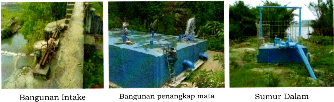
Gambar II.1 Bangunan di Unit Air Baku
