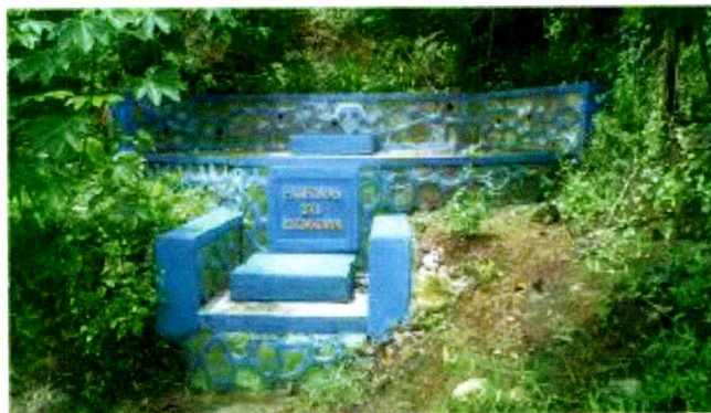
Gambar II.5 Contoh Bangunan Penangkap Mata Air
