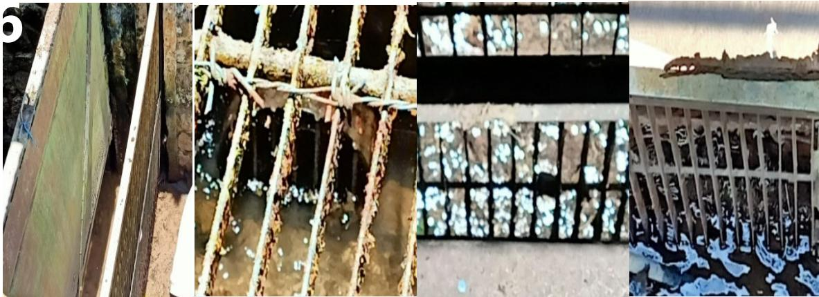
Hasil pemantauan operator yang membersihkan *intake*: lubang *barscreen* masih terlalu besar, sehingga dedaunan masih berpotensi terbawa aliran air
