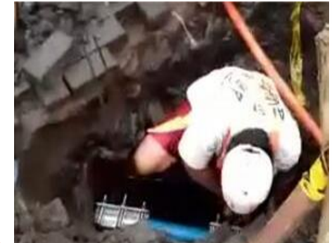
Proses penggantian pipa akibat kebocoran di kompleks perumahan Y
